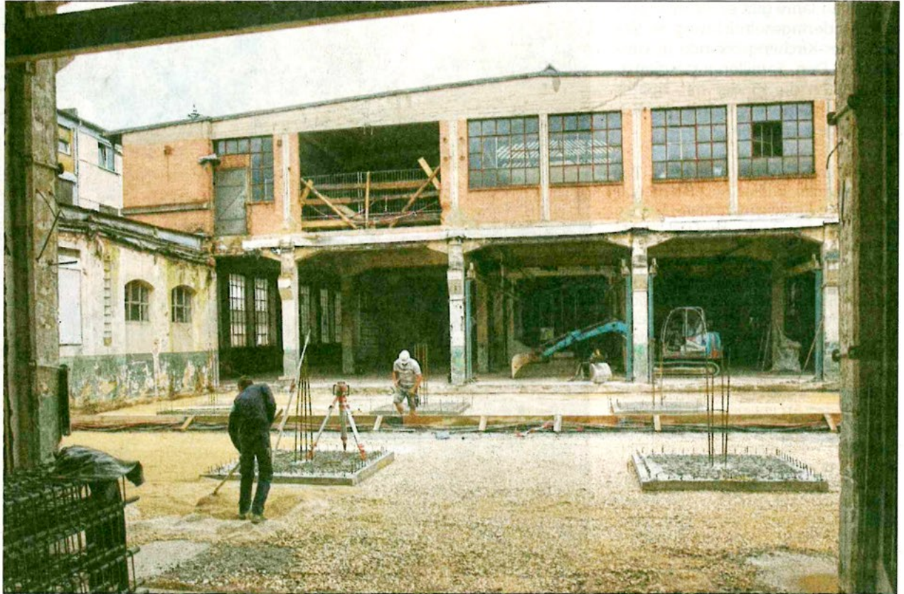
An dieser Stelle entsteht ein Neubau, die vorhandene Industriearchitektur bleibt sonst erhalten.
